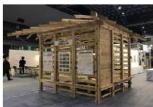
実物大の「軸組模型制作」を通し、他大学ではあまり見られない、木造軸組の仕組みを学ぶプロジェクト。「第2回九州木質建物構造展」に出展。
