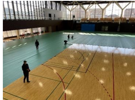
9:00～会場内に養生シートを設置
