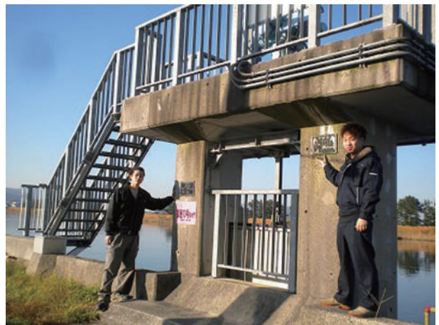
写真-2 軽量モルタルゲートの実証試験現場
