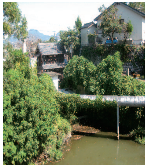
堀川の中間唐戸水門
