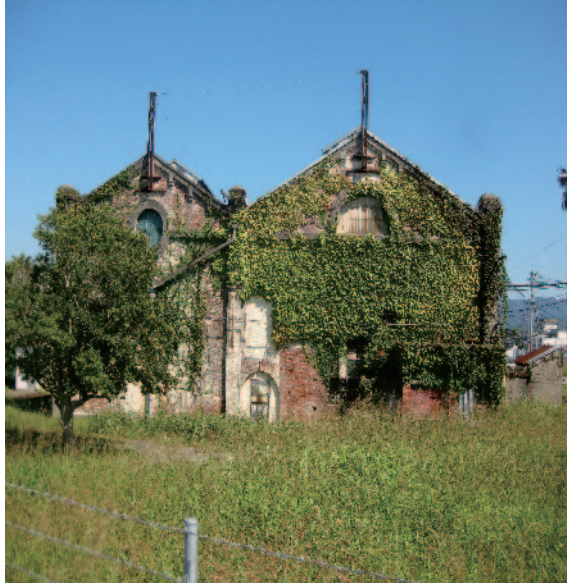
遠賀川水源地ポンプ（明治日本の 産業革命遺産）
